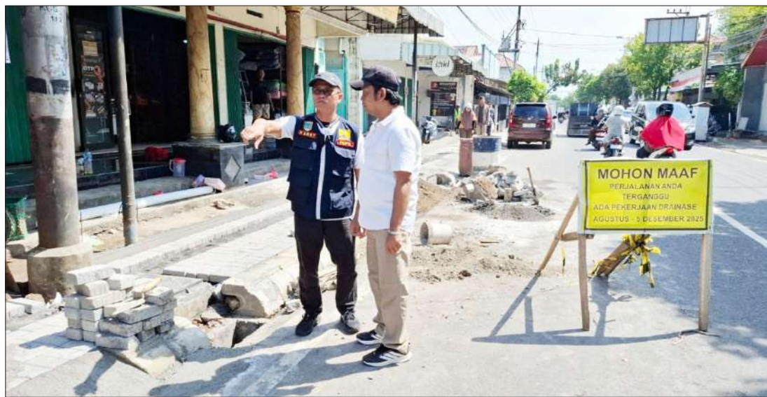
TINJAU PEKERJAAN: Kabid Binamarga pada DPUPR Kudus, Harry Wibowo (rompi PUPR), didampingi Direktur CV Nelta Pratama, Usman, meninjau pekerjaan drainase di ruas Jalan HM Subchan ZE, Jumat (31/10/2025).
