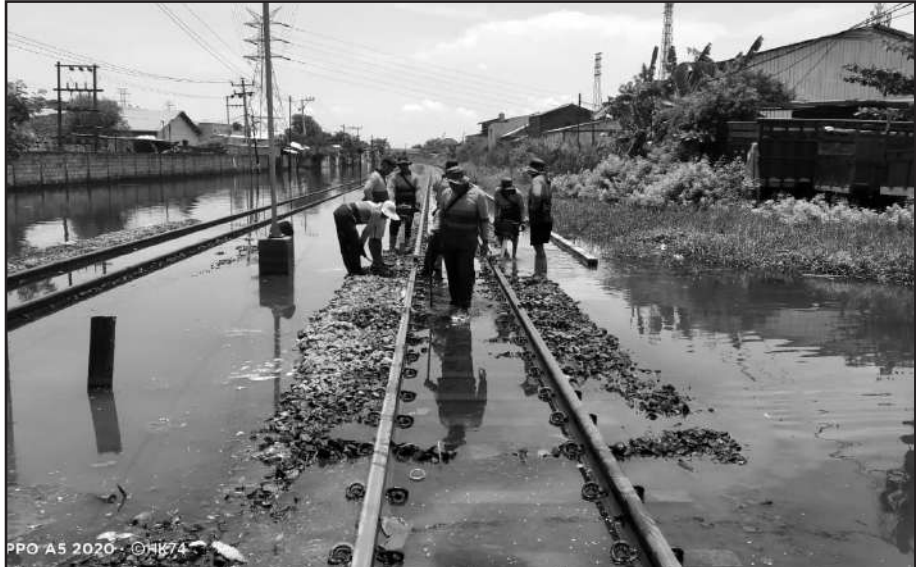
ANING KARINDRA/JATENG POS PERBAIKAN- KAI Daop 4 Semarang melakukan perbaikan dan peninggian rel kereta api di perlintasan sebidang JPL 05 Km 2+7/8 Jalan Kaligawe Raya, jalur antara Stasiun Semarang Tawang dan Alastua.
